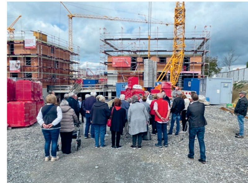
Die Mitglieder der Vertreterversammlung bei der Besichtigung der Baustelle in Kempten-Sankt Mang, Breslauer Straße
