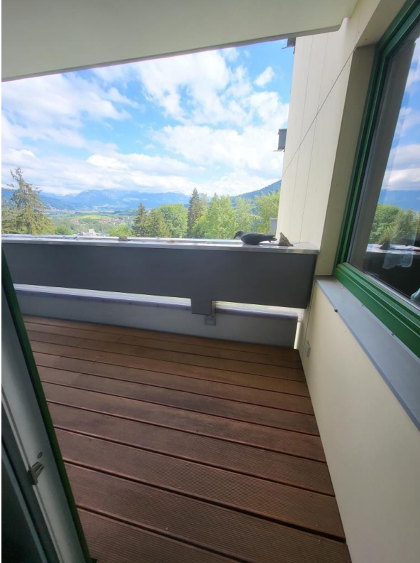
großer, überdachter Südbalkon
