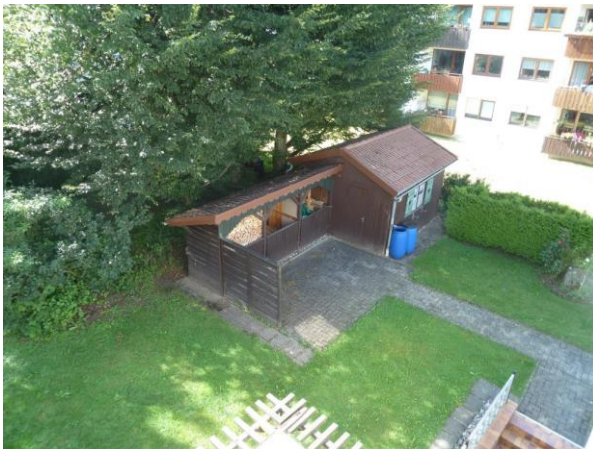
Balkonaussicht auf Holzlager/Abstellraum
