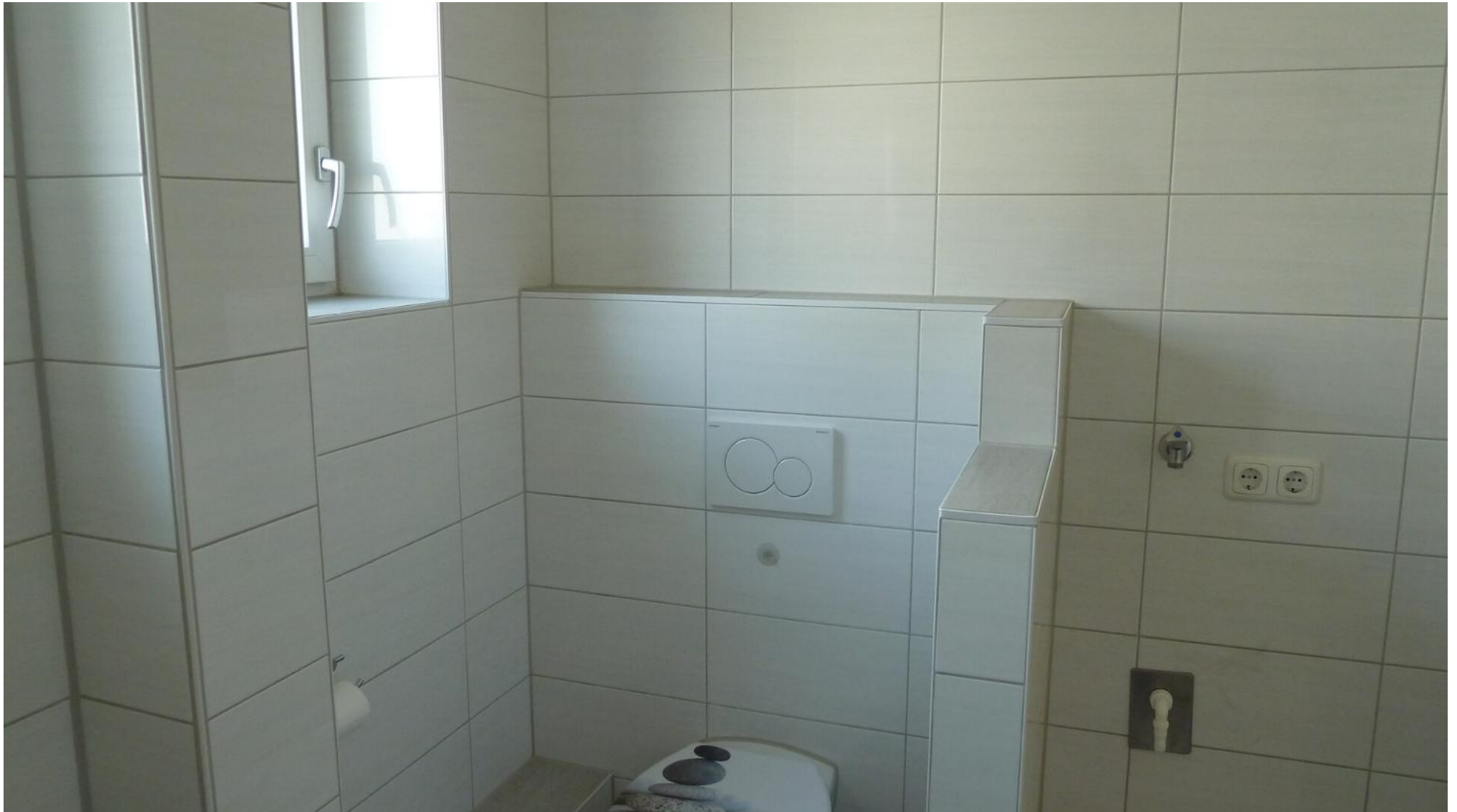
Bad mit Waschmaschinenanschluss
