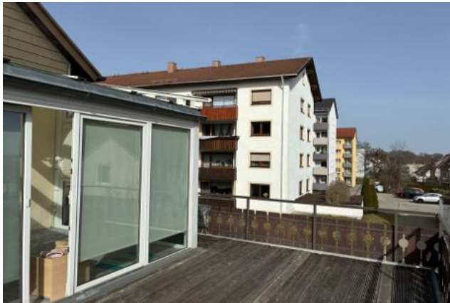
Dachterrasse auf Garage
