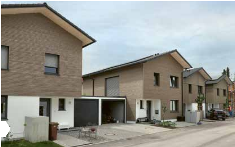
Bebauung in Durach-Weidach
