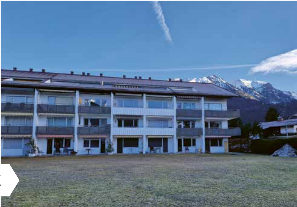
Sanierte Wohnanlage in Oberstdorf, Wannackerstraße
